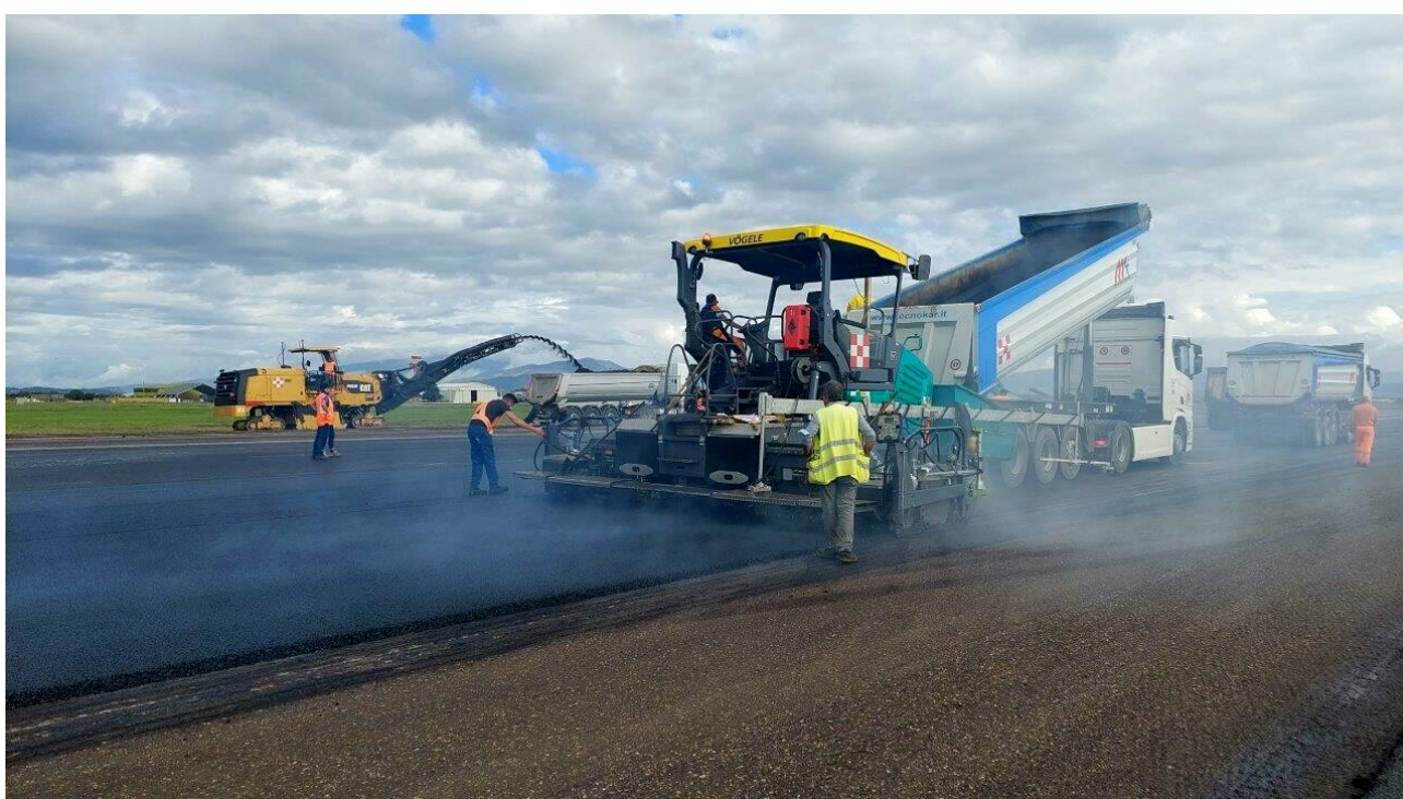
Lavori di asfaltatura alla pista dell'aeroporto Catullo
